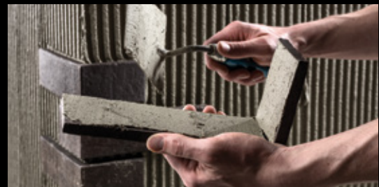
Die Eckwinkel werden im Floating-Buttering-Verfahren verarbeitet.
