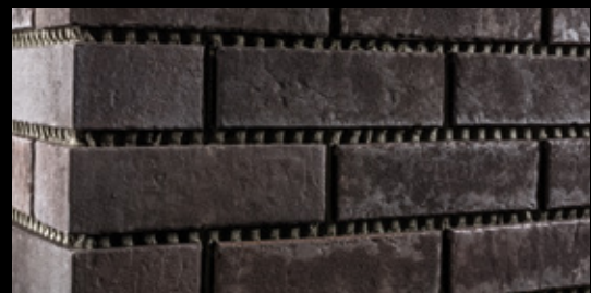
Die fertig verlegte Fläche. Nach Standzeit kann mit dem Ausfugen begonnen werden.
