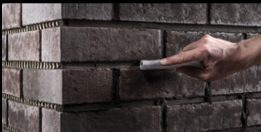
Mit der Kellenverfugung können verschiedene Optiken herausgearbeitet werden.
