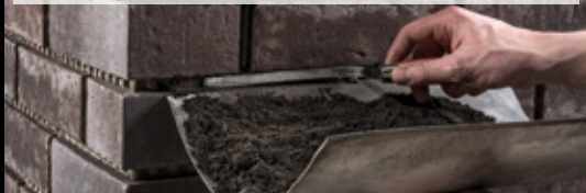
Die Verfugung mittels Fugeisen und Fugblech in der Horizontalen.
