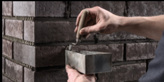
Die vertikalen Fugen lassen sich mit einem kleineren Fugeisen einfacher ausführen.
