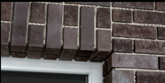
Ein perfekt mit Winkeln nachgebildeter Fenstersturz.
