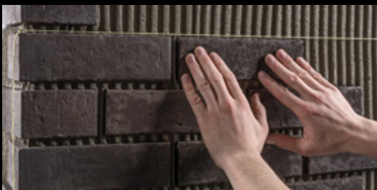
Das Setzen der Flächen-Klinkerriemchen mithilfe einer Schnur. Die Klinkerriemchen werden in das Klebebett eingedrückt.
