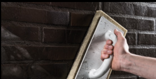
Mithilfe eines Putzbretts mit Schwamm- oder Schaumstoffauflage wird der überschüssige Mörtel diagonal abgewaschen.
