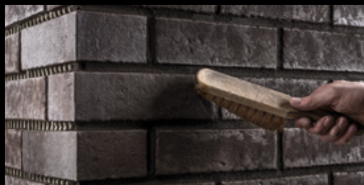
Das Abkehren der Fuge verleiht dieser eine entsprechende Struktur.
